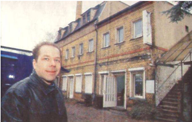
Die frühere Möbeltischlerei „Max Höhnel“ an der Markusstraße 11. Pläne für einen Jugendtreff sind fast fertig, erklärt Projektleiter Norbert Binder. Fotos: Flechtner
